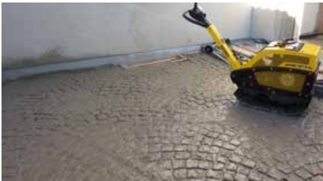
Das Abrütteln erfolgt mit entsprechend schweren Rüttelplatten, wobei bei der ersten Fugenfüllung in der gemischten Bauweise, schnell laufende Rüttelplatten zu verwenden sind.
