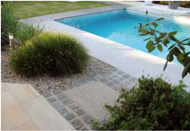
Granit Poolabdeckung auf ein herkömmliches Folienbecken geklebt
