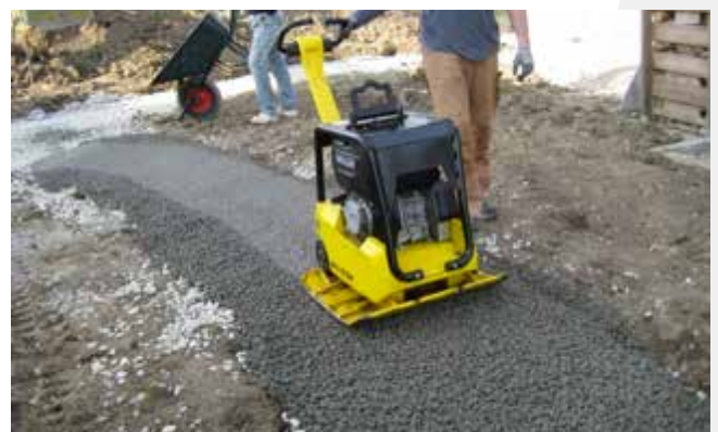
Verdichtung des Monokornbetons mit einer entsprechenden Rüttelplatte.
