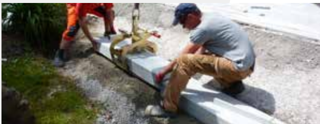
Setzen der Blockstufen mit mechanischen Setzzeugen oder Vakuumsauger.
