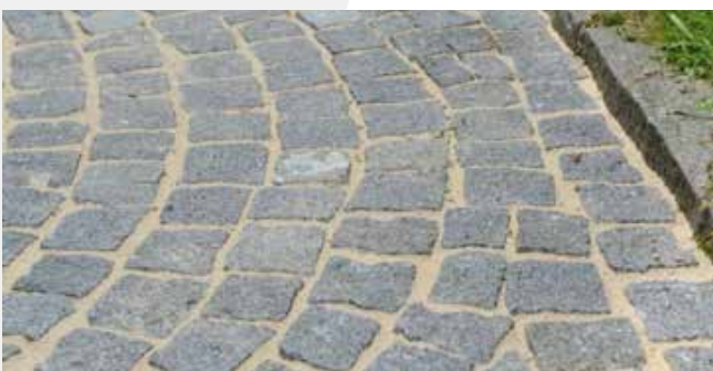
Der fertige Fugenverschluss ist relativ dicht und fest.
