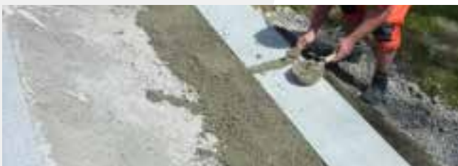
Die Stoßfugen werden mit Fugenmörtel verschlossen.
