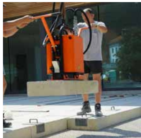
Schwerlastplatten ungebunden verlegt im Splittbett
