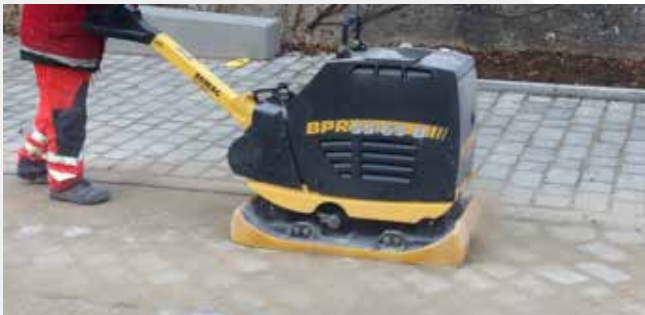
Betonsteinpflaster wird mit entsprechenden Rüttelplatten mit Kunststoffauflage abgerüttelt.
