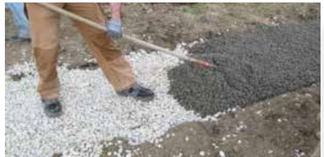
Monokornbeton Einbau auf einer Frostschutzschicht (Oberbau) aus 16/32 Rundkornmaterial.
