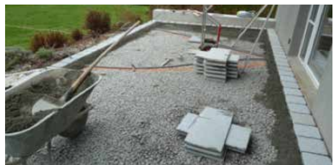
Verlegung von Bodenplatten in Drainagemörtel auf Pflasterdrainbeton.
