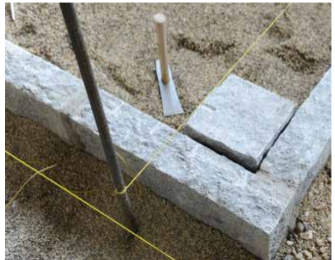
Übersetzte Absteckung: Schnur ist höher gespannt als das fertige Niveau.
