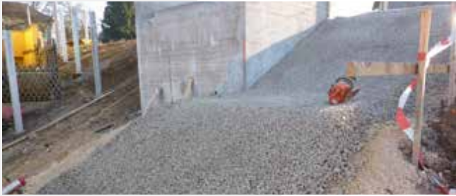
Laufplatte mit (Pflasterdrain-) Beton hergestellt.
