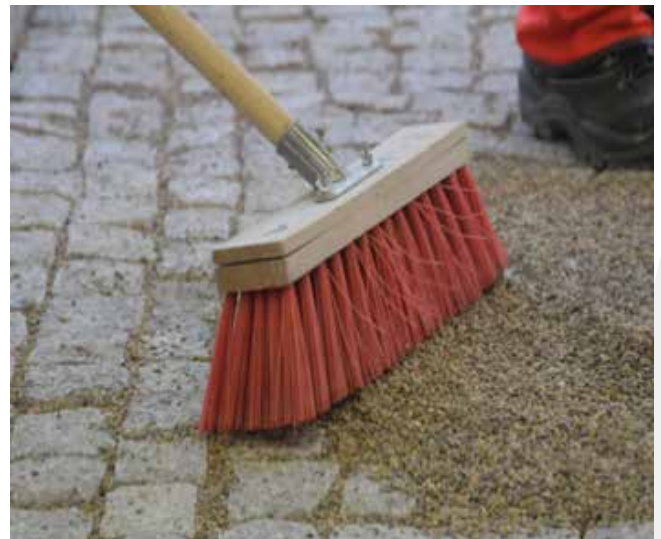
Lockeres Einkehren des Splittes in die Fugenräume. Die Fläche muss abgekehrt werden, damit kein Splitt beim Abrütteln auf der Oberfläche liegt.
