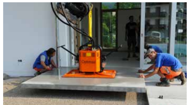
Großformatplatte ungebunden verlegt im Splittbett.
