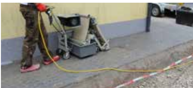
Die Reinigung hat schonend, am besten mit einer Schwammputzmaschine, zu erfolgen.
