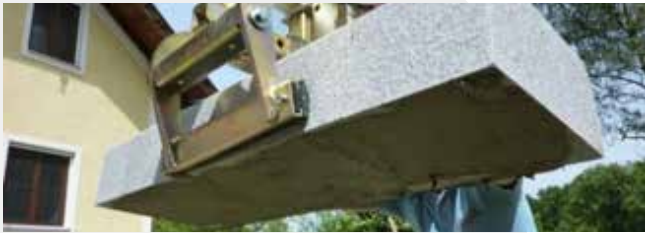
Vollflächiges Verkleben der Blockstufe auf der Lagerfläche.
