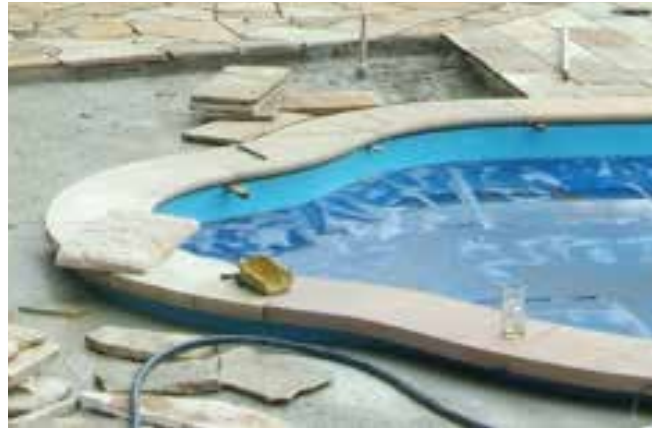
Sandstein Poolplatten auf einem Polyesterbecken geklebt
