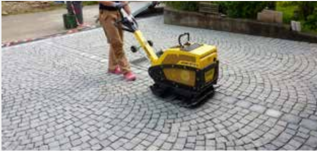
Klein- und Großsteinpflasterdecken werden mit entsprechend schweren Rüttelplatten ohne Kunststoffauflage abgerüttelt.
